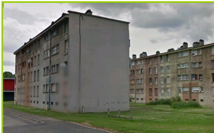
Acquisition et amélioration des copropriétés dégradées d'Uckange en Moselle
